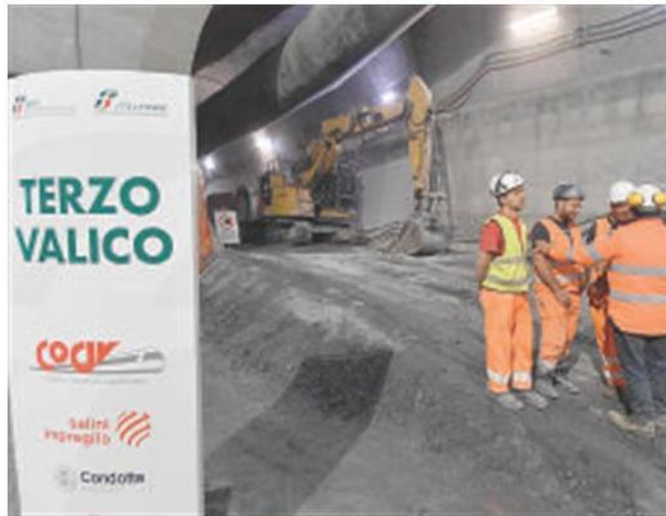
Al lavoro in un tunnel del Terzo valico , tratto alessandrino
